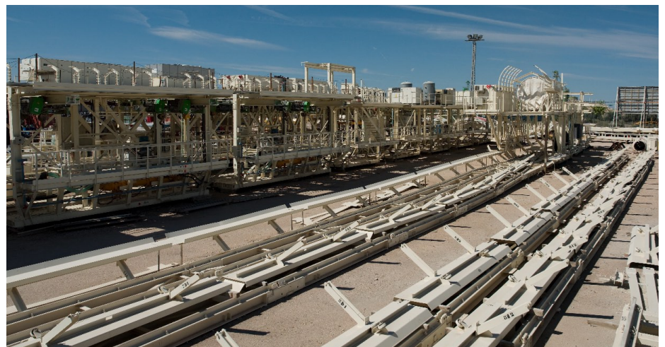
Vista de tuneladora
