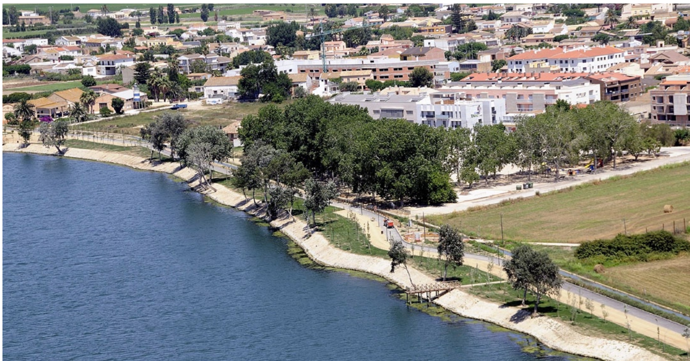
Vista aérea de la obra
