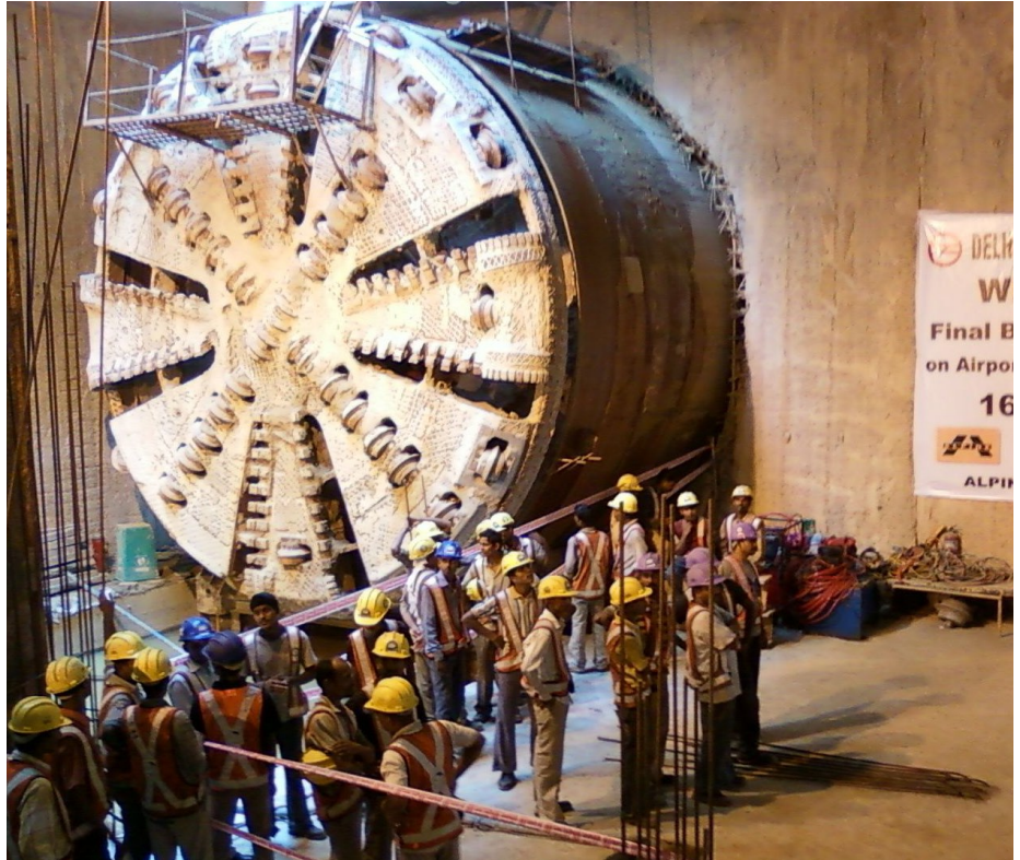
Cale del túnel
