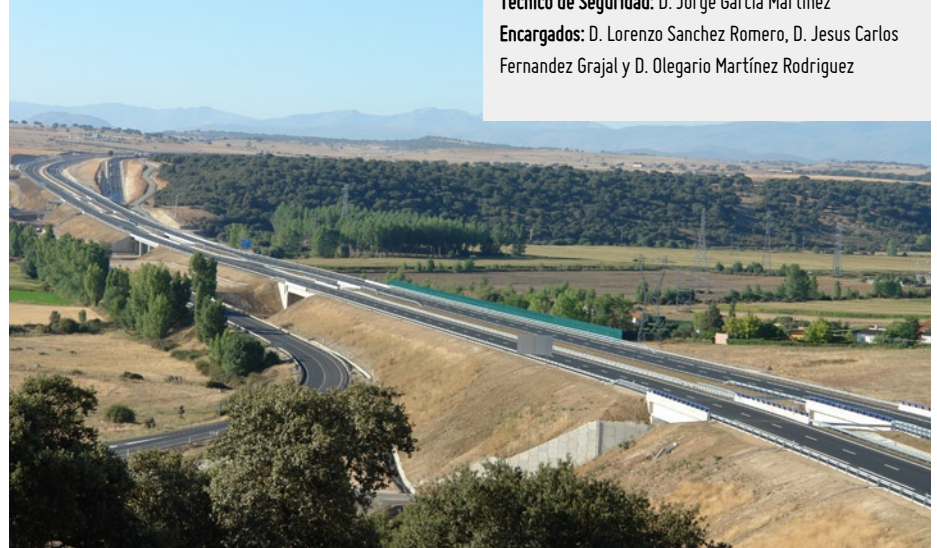
Vista aérea de la obra
